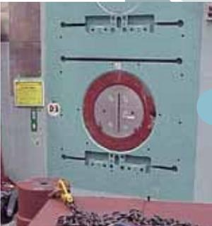
Plusieurs tubes traversant la paroi du réacteur permettent à des neutrons de sortir sous forme de faisceau. Les neutrons excédentaires sont absorbés par la paroi du réacteur.
